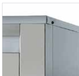
Acabamentos exteriores em aço inox.
