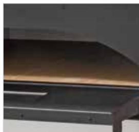
Isolamento em lã de rocha evaporada.
