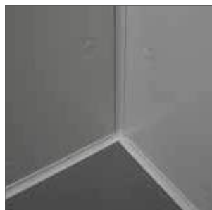
Perfil sanitário integrado para uma melhor higiene e fácil limpeza do recinto.
